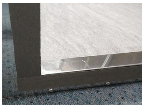
扉部の導電性・封止が劣化することでシールド性能が低下する為、扉部のガスケットを全て交換しております。
