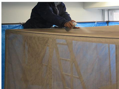
EMC 簡易ルームの天井と側面（計5面）に導電防錆スプレーをテント内部、外部から噴霧。
